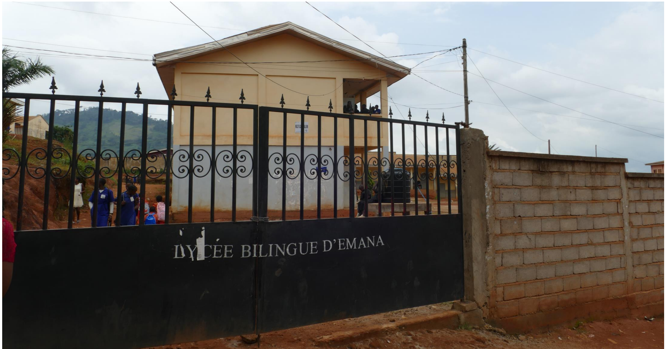
Vue de face du Lycée Bilingue d'Emana / Front door
